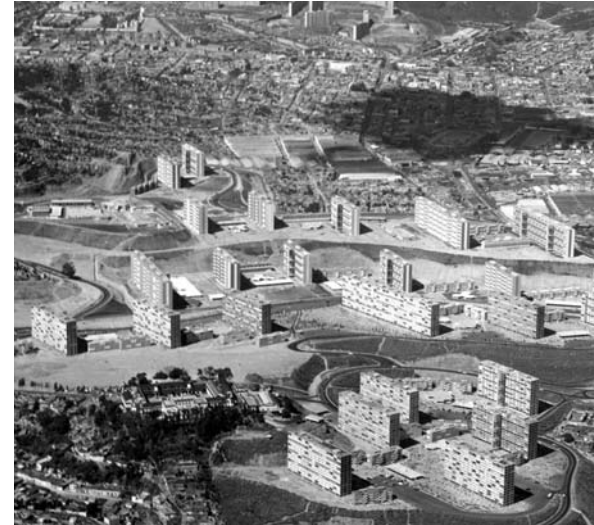
Wohnbauprojekt 23 de enero, Caracas 1960. Foto: Paolo Gasparini
